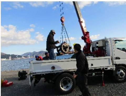
クレーンを使って発動機を下ろす
